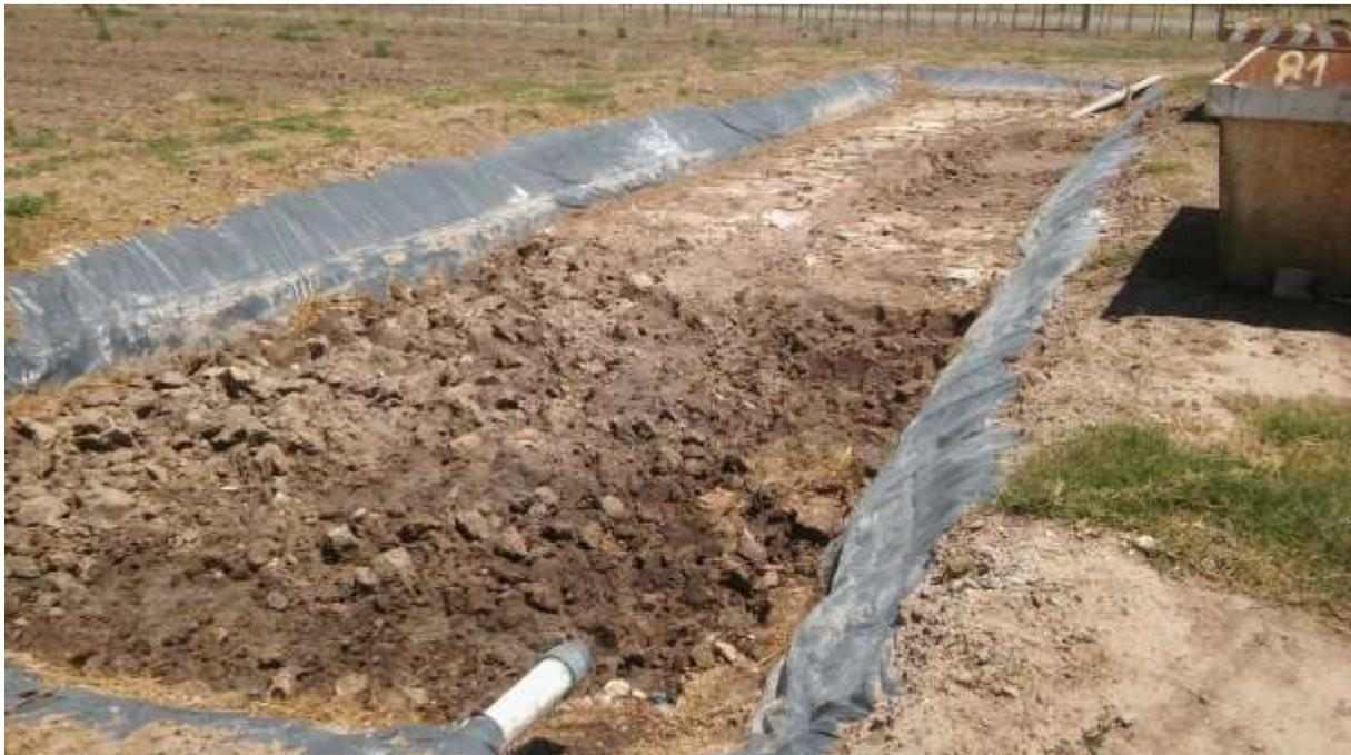
Foto N°9 Playa de lodos en proceso de secado.
