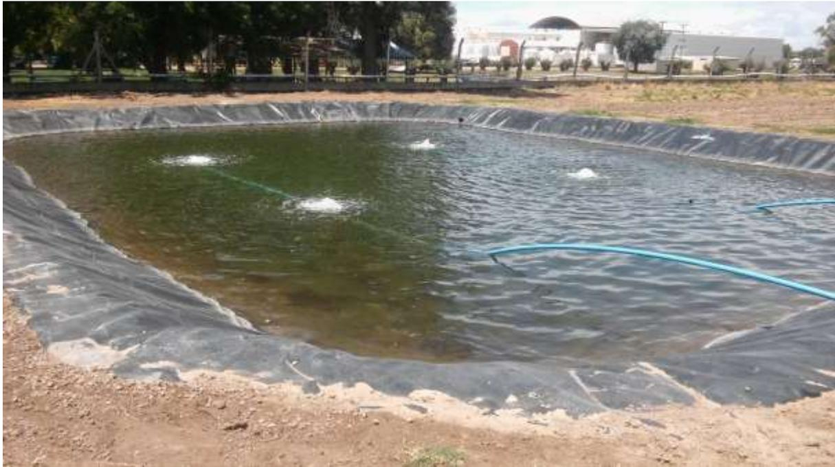
Foto N° 10 Pulmón en proceso de aireación.
