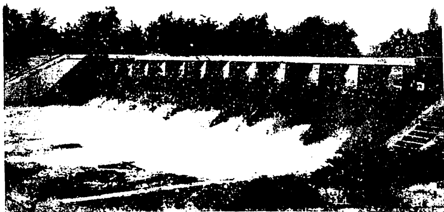
For. 3 - El canal principal a la altura de Cinco Saltos, en el valle superior.
