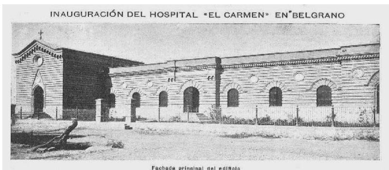
Fachada principal del edificio
