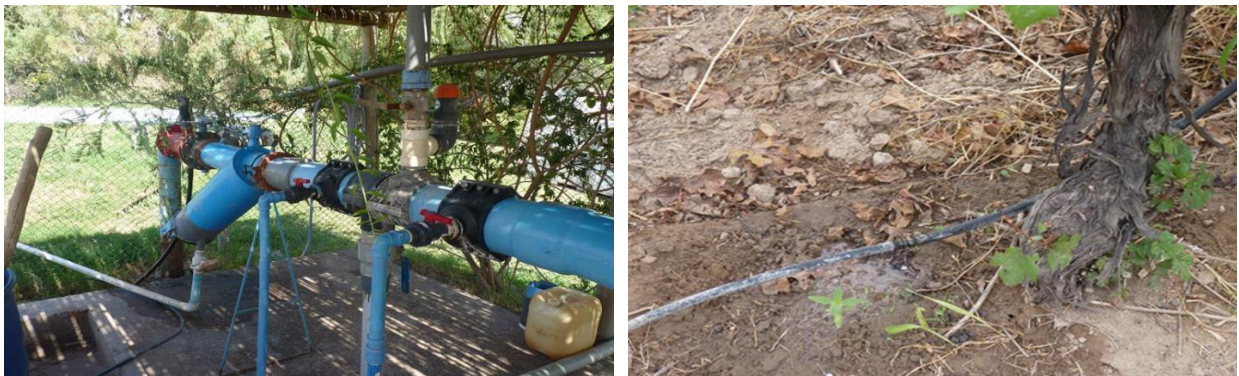
Fig.12. (Izq.) Sistema de Riego en VC SA: entrada del agua subterránea hacia tanque australiano.
