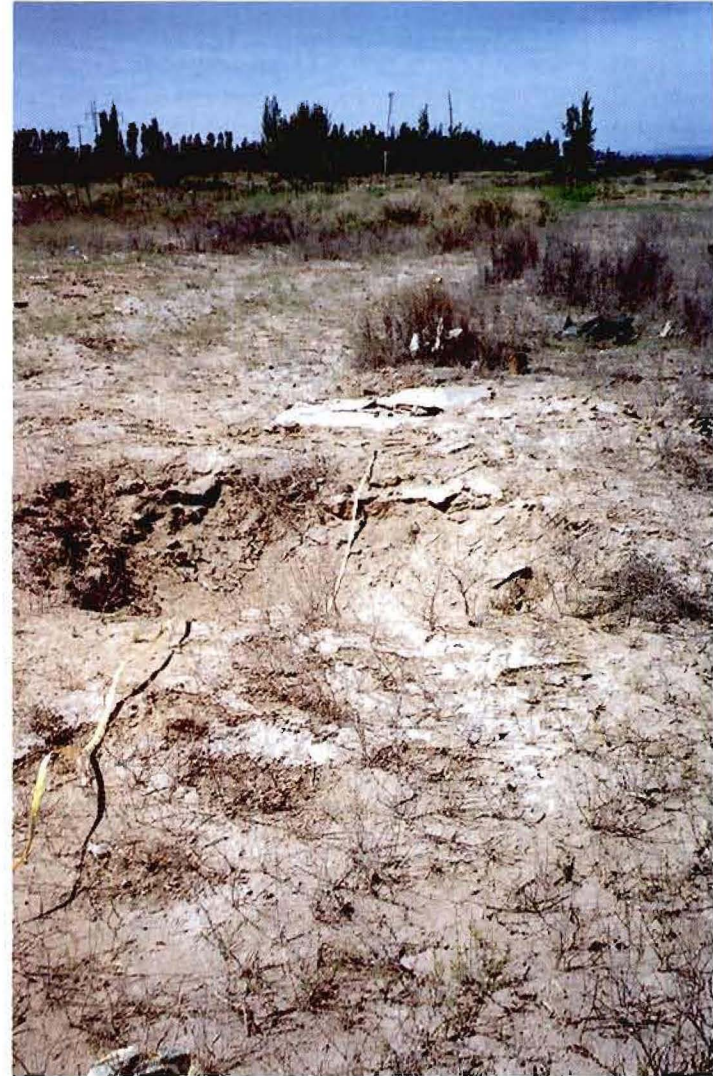
Figura 5 : Manifestación reciente de subsidencia superficial localizada al SW del sitio mostrado en figura 1. Notar la significativa salinización del suelo. Fotografía: 18/11/2000.
