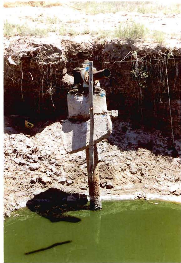
Figura 3 : Vista frontal de la bomba de extracción en relación a la cerca. Observar la elevada salinización del suelo y de los depósitos superficiales. Fotografía: 17/12/1999.
