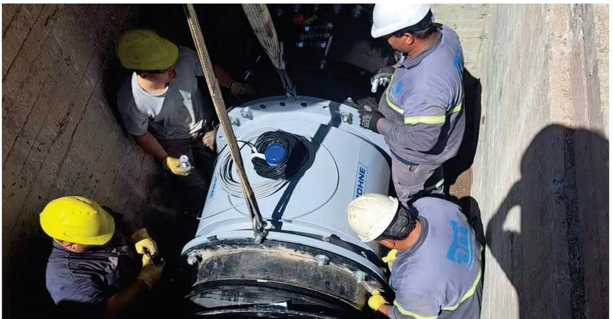
*Figura 22: Nuevo caudalímetro DN 900*
