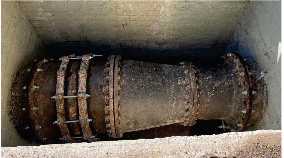
*Figura 21: Acueducto DN 900 previo a la colocación del caudalímetro*
