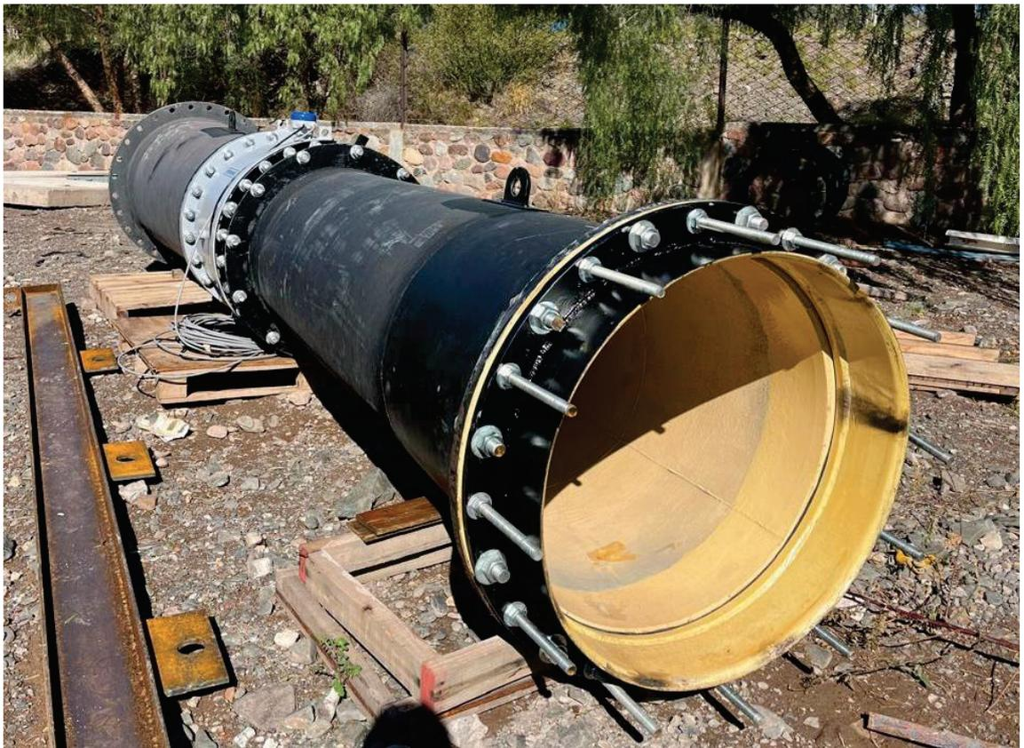
*Figura 24: Nuevo caudalímetro DN 700*
