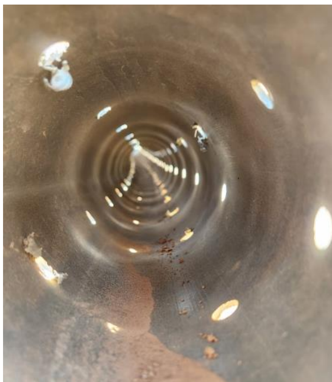
Figura 6: Disposición cruzada de las perforaciones a lo largo del tubo de PVC. Fuente: Imagen propia, tomada el día 22 de marzo de 2025.
