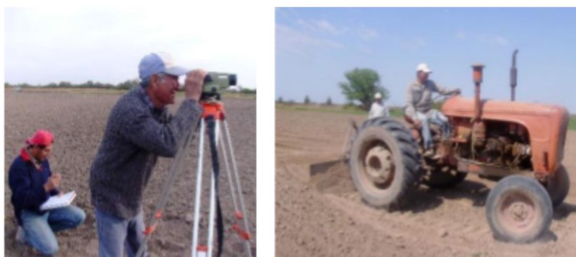
Figura 2- A la izquierda, relevamiento altimétrico realizado por productores, a la derecha primera experiencia de nivelación.
