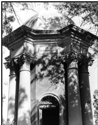
Fig. 77 – Detalle del coronamiento (Foto archivo del cementerio)
