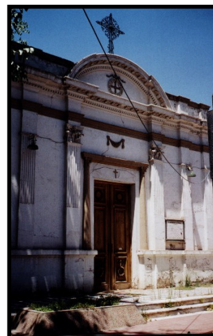
Fig. 7 - Frente de la capilla (Foto E. S.)
