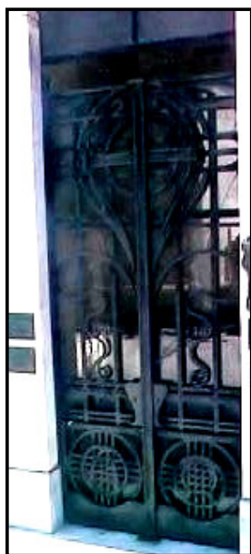
Fig. 33- puerta principal de la bóveda (Foto E. S.)
