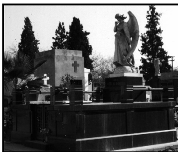
Fig. 40 – Vista general de la bóveda (Foto E. S.)
