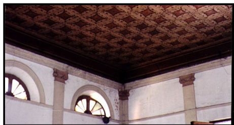
Fig. 12 - Detalle del techo; interior de la capilla (Foto E. S.)
